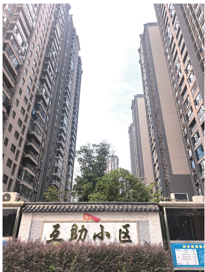
衡阳市蒸湘区互助安置小区。
