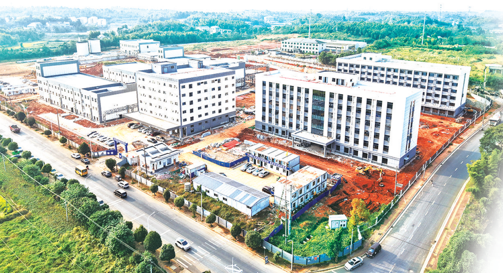
湖南宏晨制药有限公司高端生物医药原料及中间体绿色智造基地项目建设现场。张佳伟 摄
