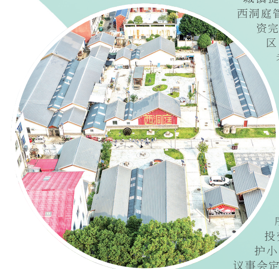
西洞庭管理区城镇提质改造中，倾听居民诉求，补齐养老、充电、停车配套基础设施，让老房子适配新时代的生活。
