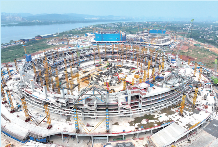
9月21日，长沙奥体中心“一场两馆”主体封顶。赵持 摄
