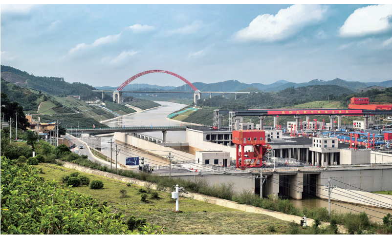
9月16日拍摄的平陆运河马道枢纽。新华社记者 刘卫兵 摄
