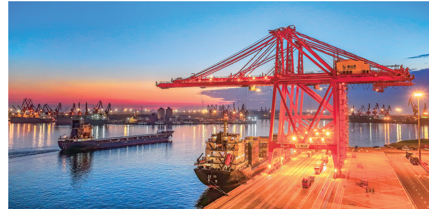
河北省唐山港京唐港区的繁忙景象(2026年7月15日摄，无人机照片)。
