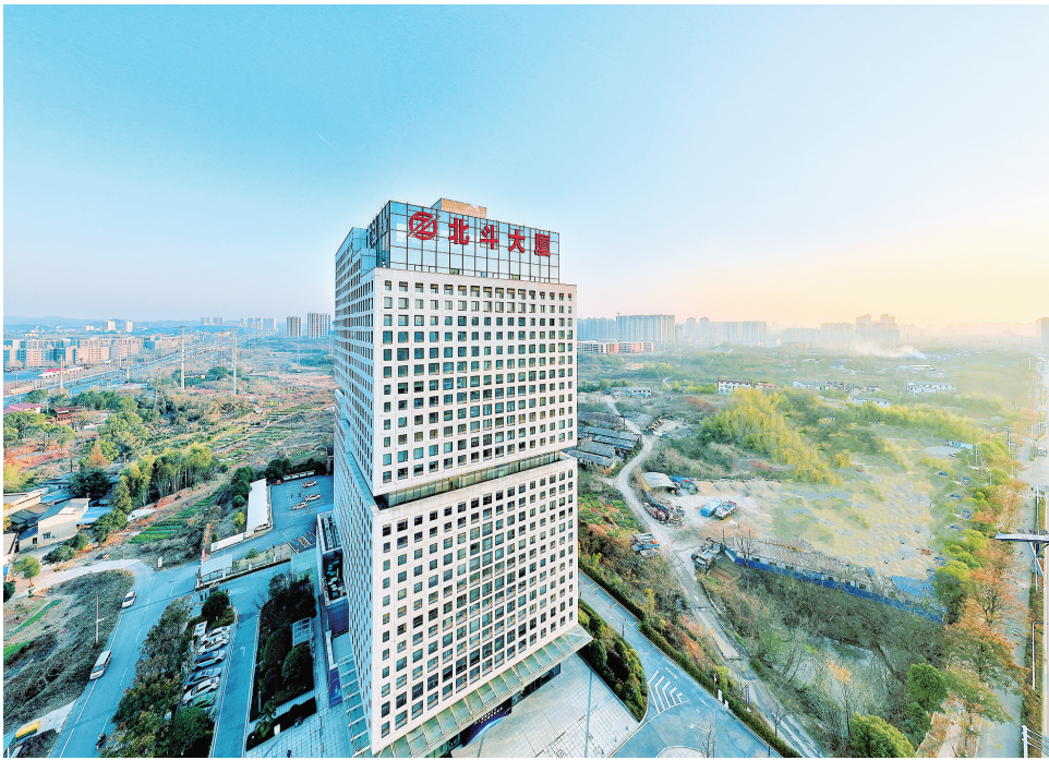
位于株洲经开区的北斗大厦。(资料图片)
