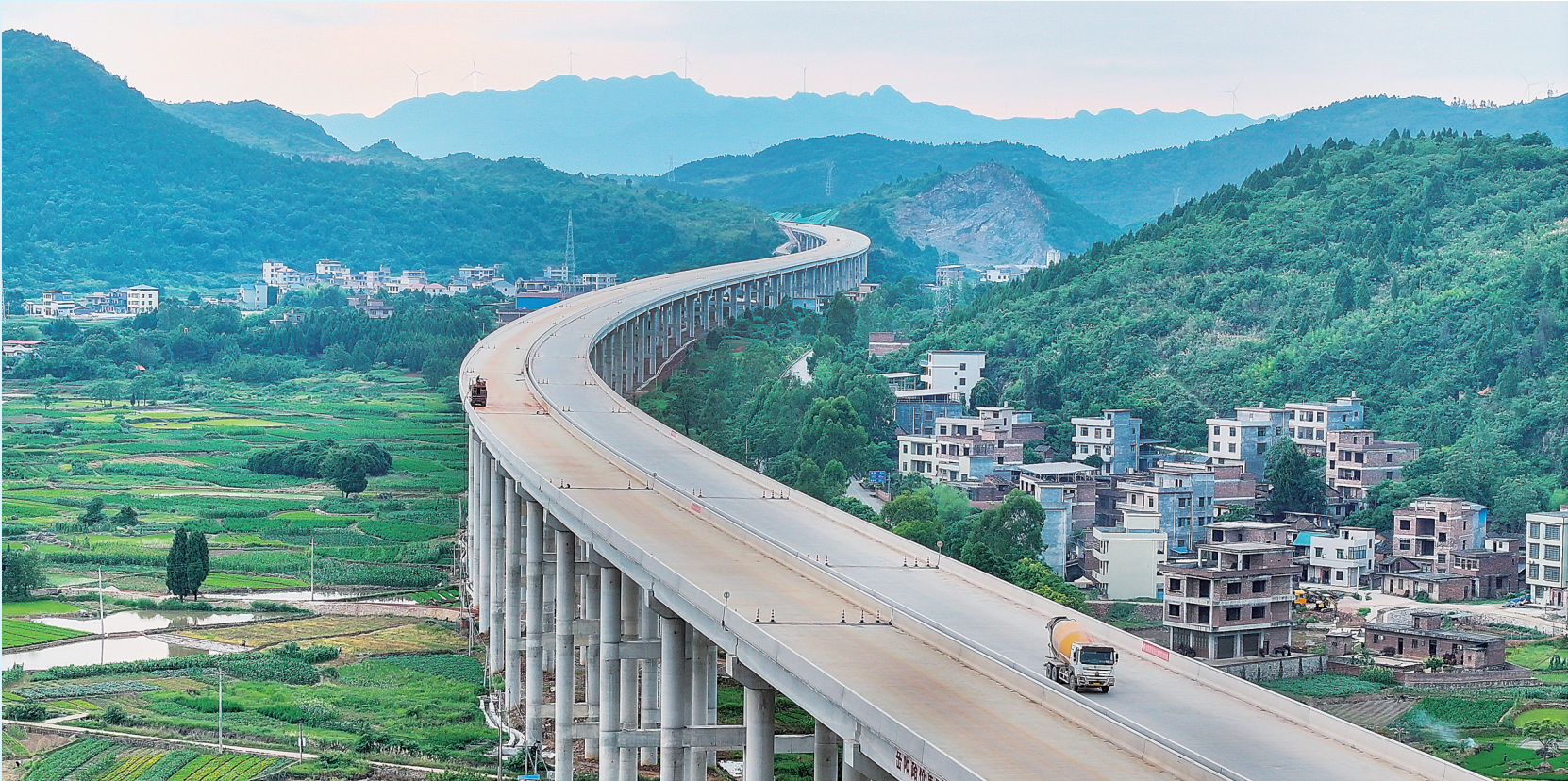
6月2日,新田县龙泉街道刘家桥村,建设中的桂(东)新(田)高速刘家桥特大桥,宛如巨龙蜿蜒于青山田园间,与村落相映成景。刘贵雄 陈祉凝 摄影报道(湖南图片库)
