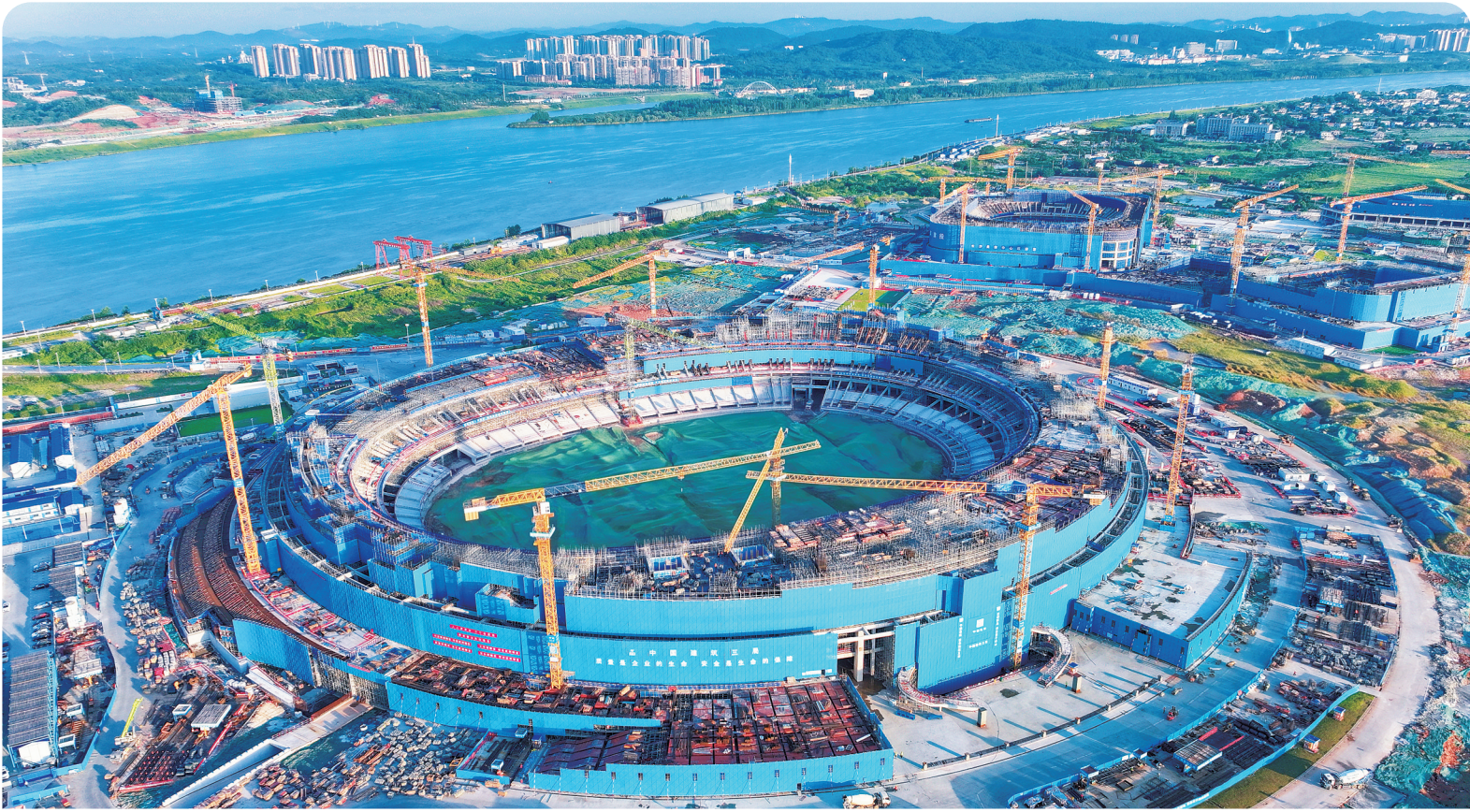
7月10日，长沙奥体中心项目建设如火如荼。目前，该项目“一场两馆”(体育场、体育馆、游泳馆)正全力冲刺主体结构封顶，预计2028年底竣工交付。
