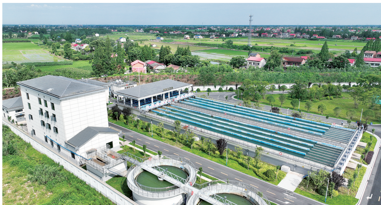
7月8日，沅江市北部农村集中供水项目第一期水厂一瞥。
