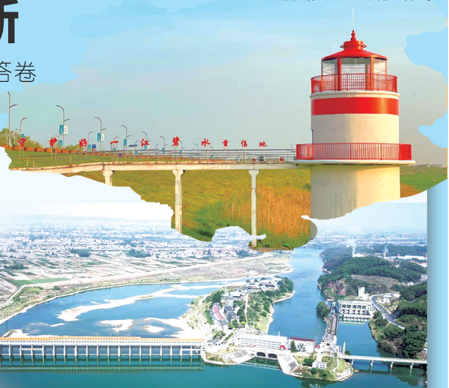
岳阳市“守护好一江碧水”生态文明建设君山示范区项目。
