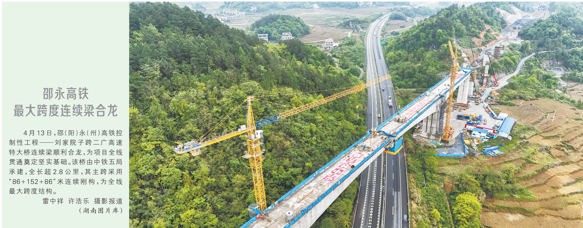
邵永高铁最大跨度连续梁合龙
