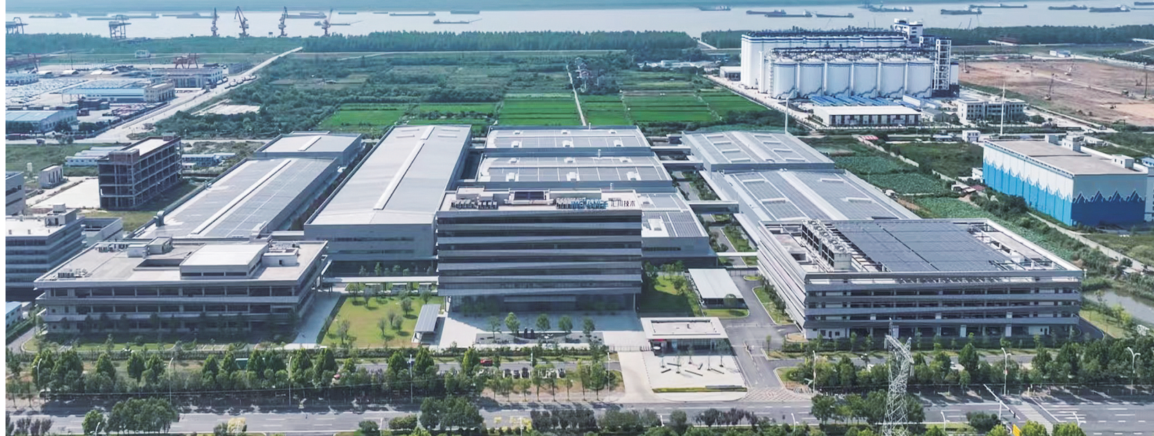
位于长江之滨的岳阳汇川技术有限公司智能化工厂。
