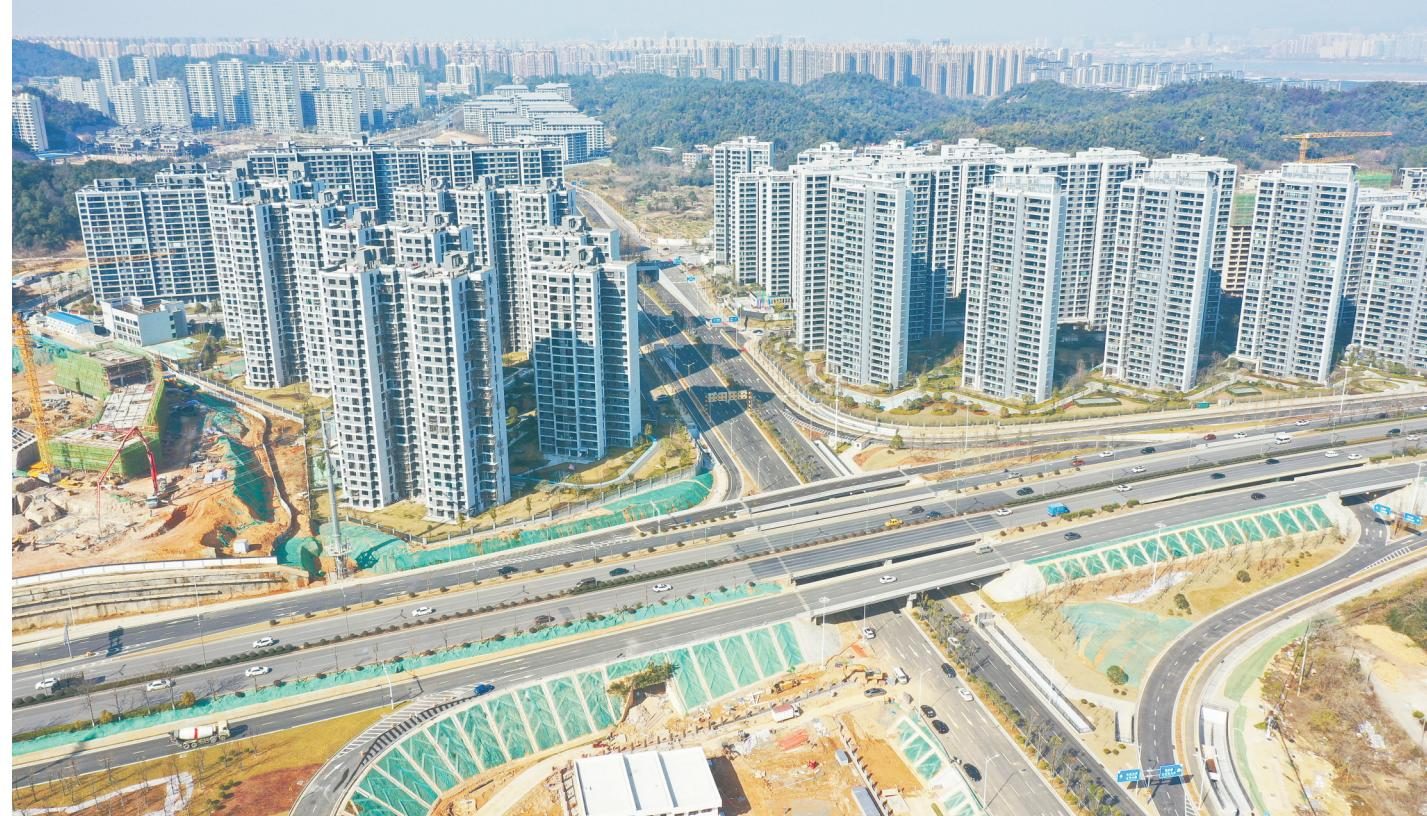
1月14日，长望路二期西延线（金星路—北二环段）项目建设已完工，进入竣工验收阶段，即将放开交通。这是长望路西延线工程的最后一个标段，全长约1.71公里，规划路宽46米，双向6车道，设计时速60公里。长望路西延线是长沙市快速路东西向主干路的重要一横。全线通车后对加强长沙主城区、湖南湘江新区与望城高星组团之间的对接，促进新区社会经济发展发挥重要作用。
