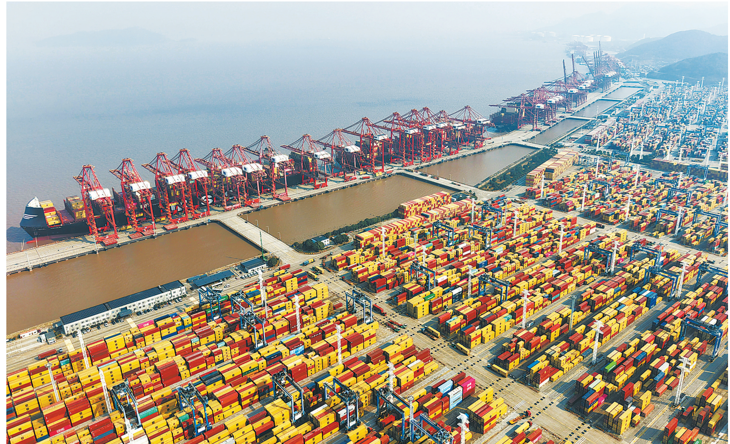
全球首个年货物吞吐量超14亿吨大港诞生 记者近日获悉，2025年宁波舟山港完成货物吞吐量超14亿吨，连续17年位居全球第一，宁波舟山港也由此成为全球首个年货物吞吐量超14亿吨的大港。图为2026年1月8日拍摄的宁波舟山港穿山港区（无人机照片）。 新华社记者 黄宗治 摄
