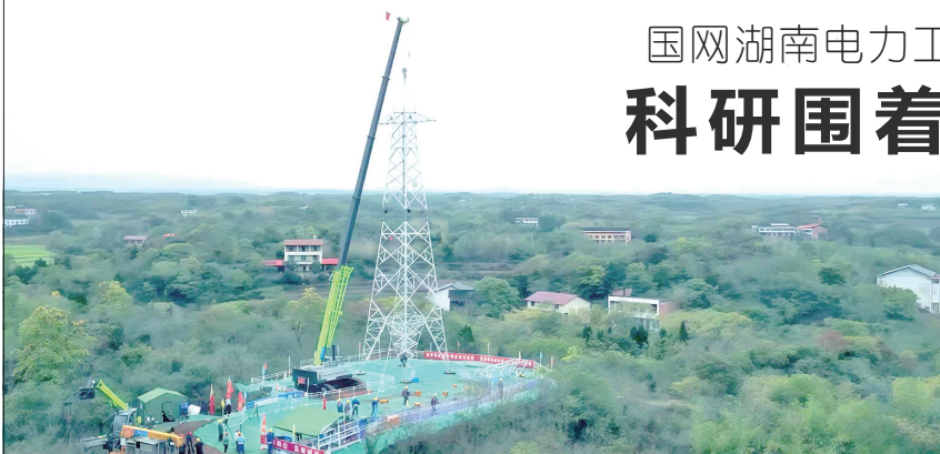
70米级履带式电建起重机的湖南船山—鹤岭第二回500千伏线路工程施工现场进行铁塔组立。肖权一 摄
