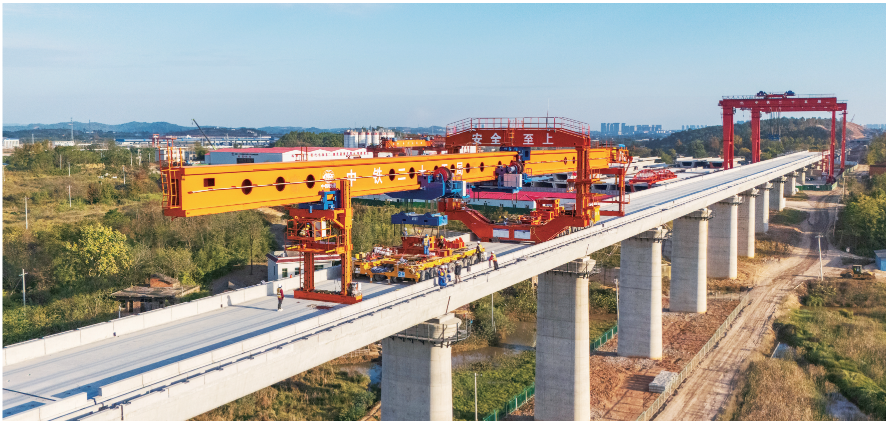
11月20日,在位于永州市的邵(州)永(州)高铁跨芦洪江特大桥施工现场,中铁二十五局施工人员正在进行架梁作业。邵永高铁全长约96公里,设计时速350公里,是国家“八纵八横”高铁网中呼和浩特至南宁通道的重要组成部分,建成后对完善区域铁路网布局、促进中部地区高质量发展具有重要意义。雷中祥 摄(湖南图片库)
