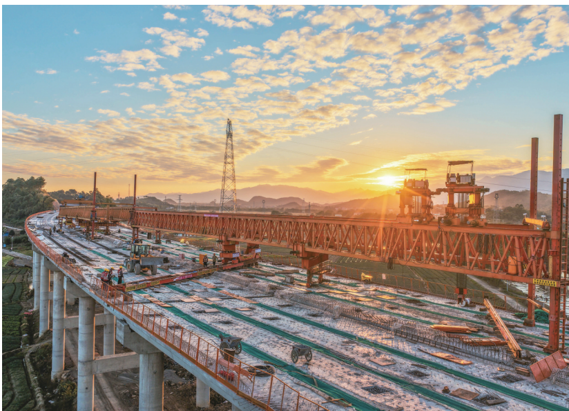
11月20日,道县营江街道,零(陵)道(县)高速桥梁施工现场,工人在忙碌作业。该项目北接永零高速,南至厦蓉高速。建成后,将极大改善湘南山区交通状况,有效推动当地经济高质量发展。 蒋克青 摄(湖南图片库)
