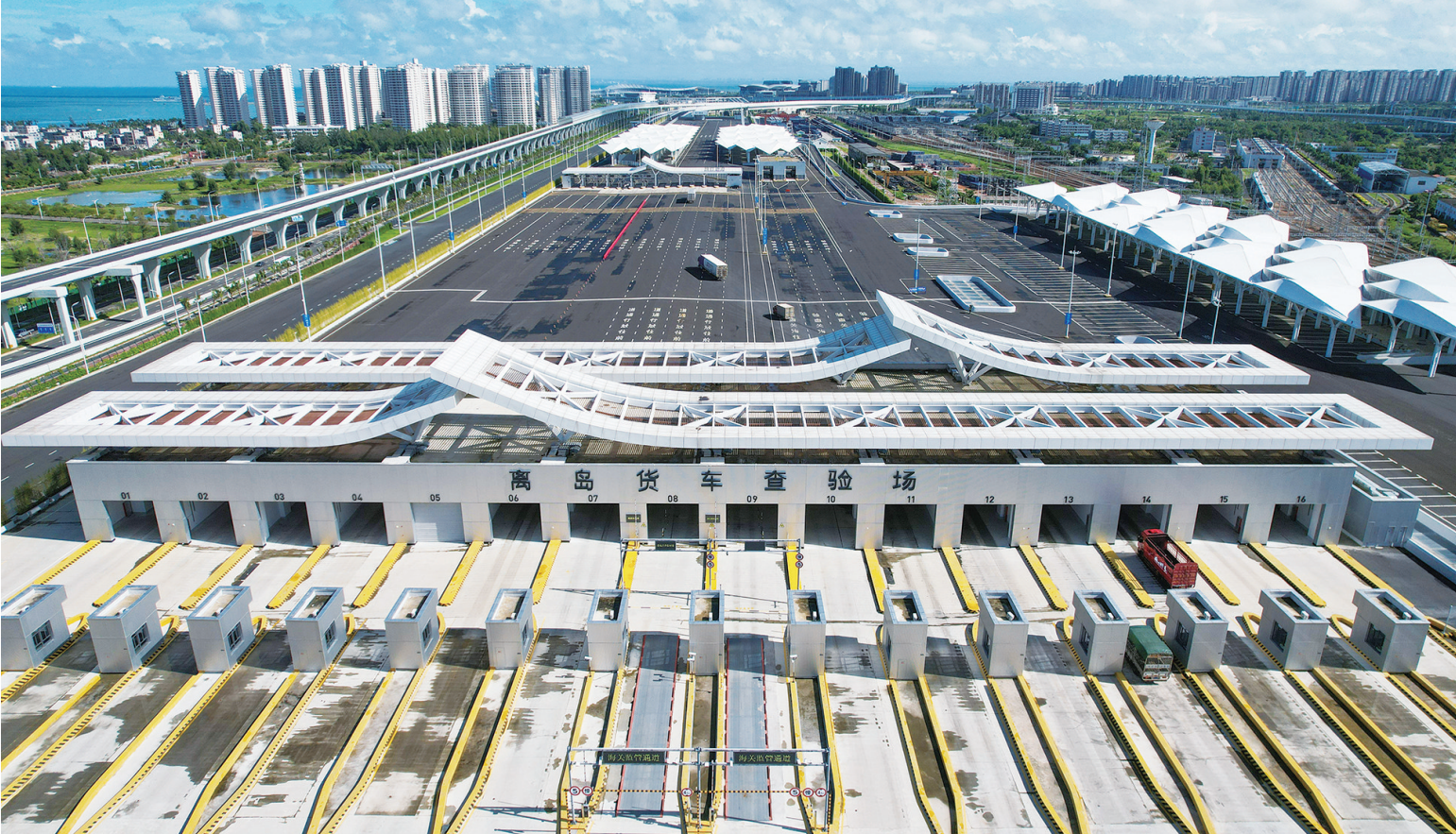
2025年9月17日,离岛货车通过海口新海港和南港“二线口岸”(货运)集中查验场,开往港区(无人机照片)。
