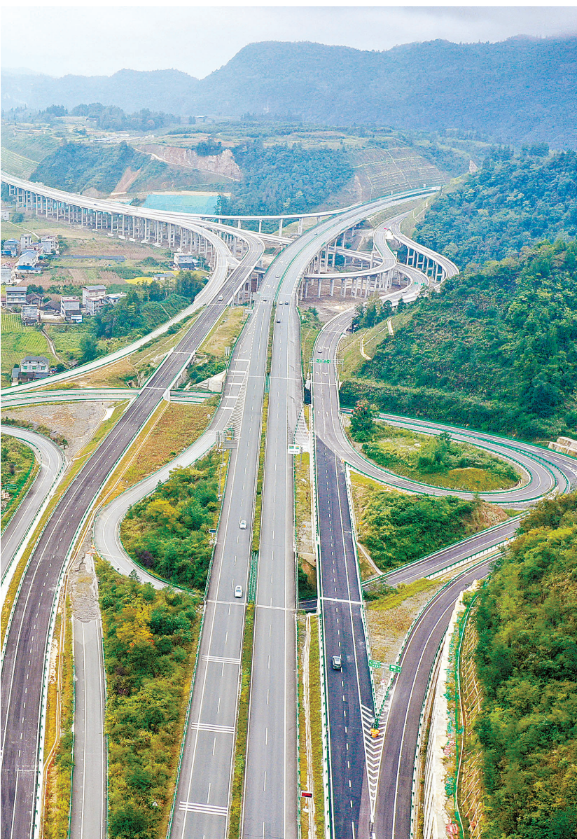
9月29日,桑(植)龙(山)高速公路龙山茅坪枢纽远眺。当天,桑龙高速公路正式通车。 曾祥辉 摄(湖南图片库)
