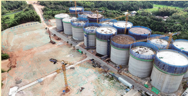
省储粮公司开慧库区扩建工地。
