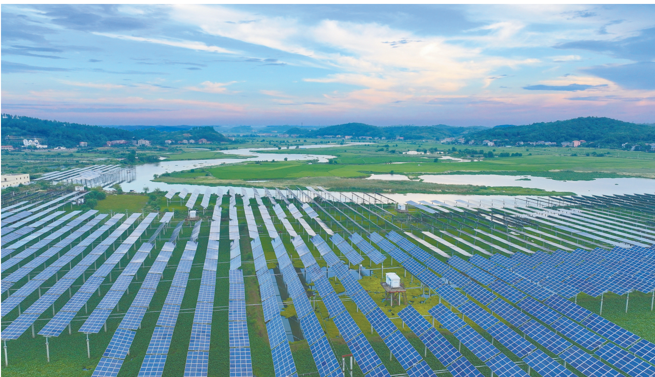
8月28日,衡东县大浦镇,夕阳下的光伏电站。近年来,该县大力发展新能源产业,多个风力发电和光伏发电项目相继投入运行,进一步推动生态效益与经济效益双赢。 曹正平 王峥 摄影报道(湖南图片库)
