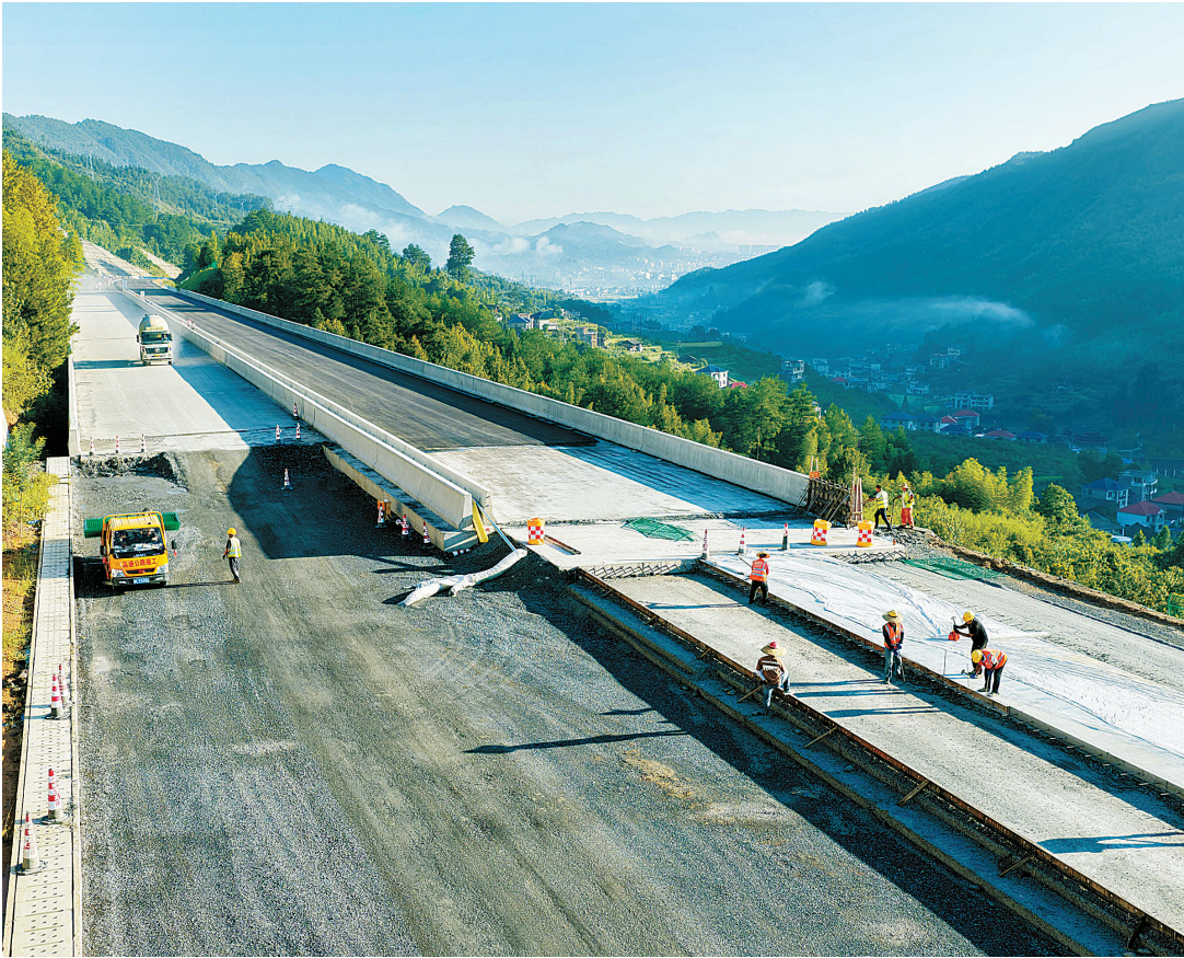
8月25日,城龙(湖南城步至广西龙胜)高速一标段城步苗族自治县儒林镇贺家寨段,工人在加紧进行路面施工作业。目前,城龙高速各标段在保障质量与安全的前提下,全力推进路面施工,同步完成机电、交安、绿化等工程,确保2026年春节前竣工通车。
