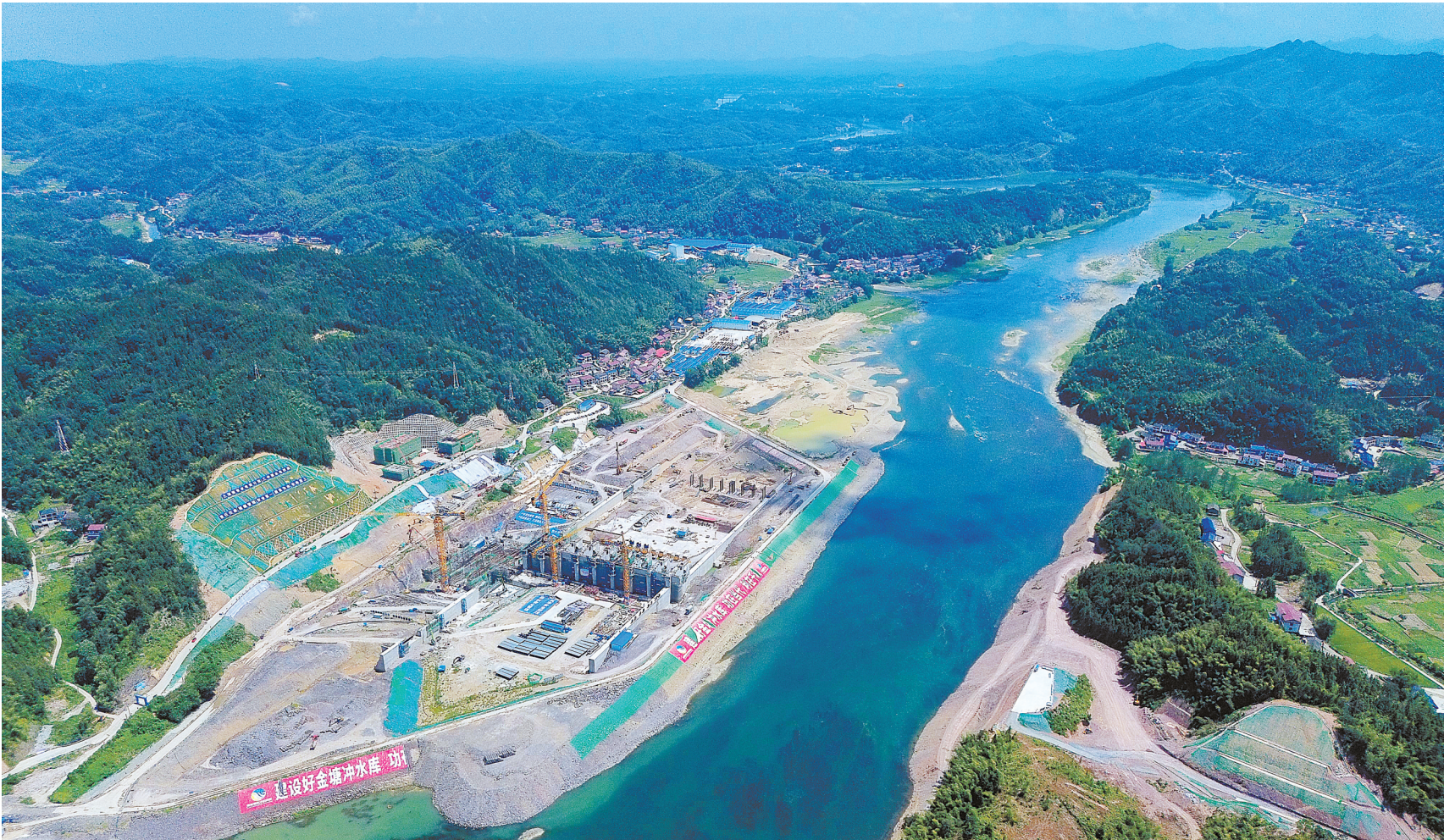
8月26日，位于益阳的金塘冲水库枢纽工程施工现场一片繁忙。该工程是湖南省“十四五”水安全保障规划的标志性工程之一，以防洪为主，结合灌溉、发电，兼顾航运、生态等。项目总投资超98亿元，总库容2.14亿立方米。
