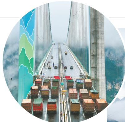
8月21日，在建世界第一高桥——贵州花江峡谷大桥正式启动荷载试验。2022年开工建设的花江峡谷大桥，跨越被誉为“地球裂缝”的花江大峡谷，是贵州省六枝至安龙高速公路的控制性工程。大桥为钢桁梁悬索桥，全长2890米，其中主桥跨径1420米，桥面至水面高度625米。
