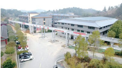
耒阳市新建浔江灌区工程。(安徽建工水利南方分公司供图)
