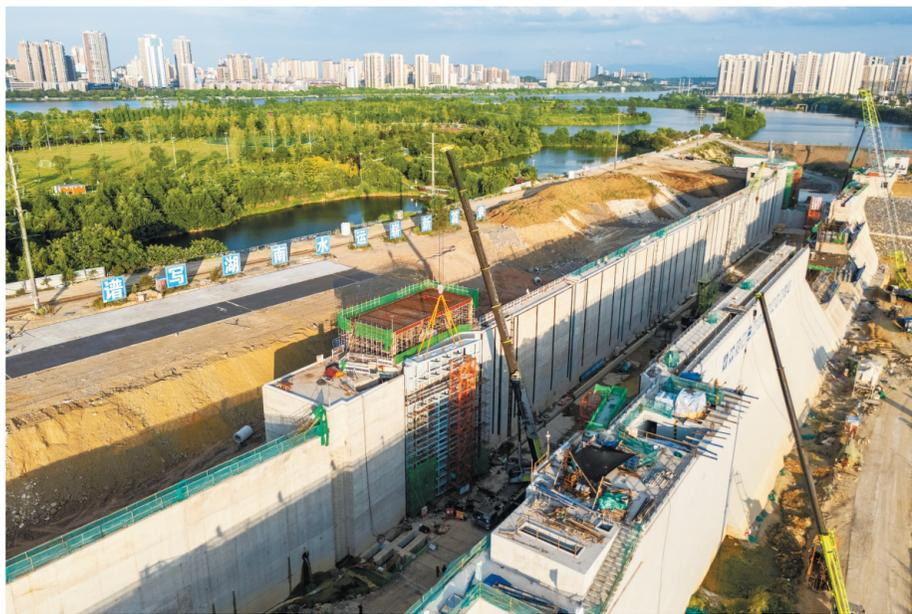
8月8日,湘江永州至衡阳三级航道建设三期工程潇湘船闸工程建设现场,中交二航局工人顺利完成下闸首人字门节门叶吊装,标志着该项目人字门全部安装完成。 雷中祥 摄(湖南图片库)
