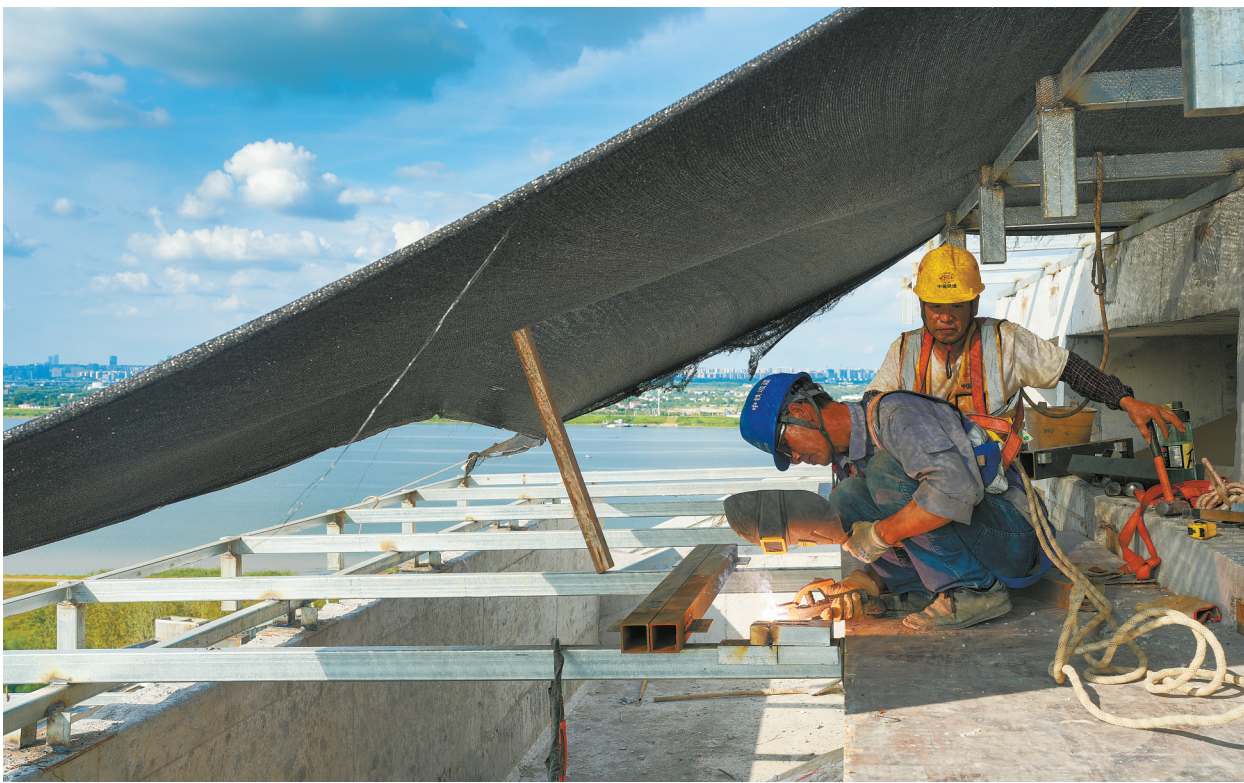
8月6日,湘江科学城项目建设现场,中铁城建的工人正在进行玻璃幕墙施工。尽管近期持续高温天气,建设者们仍坚守岗位,错峰施工,确保工程有序推进。
