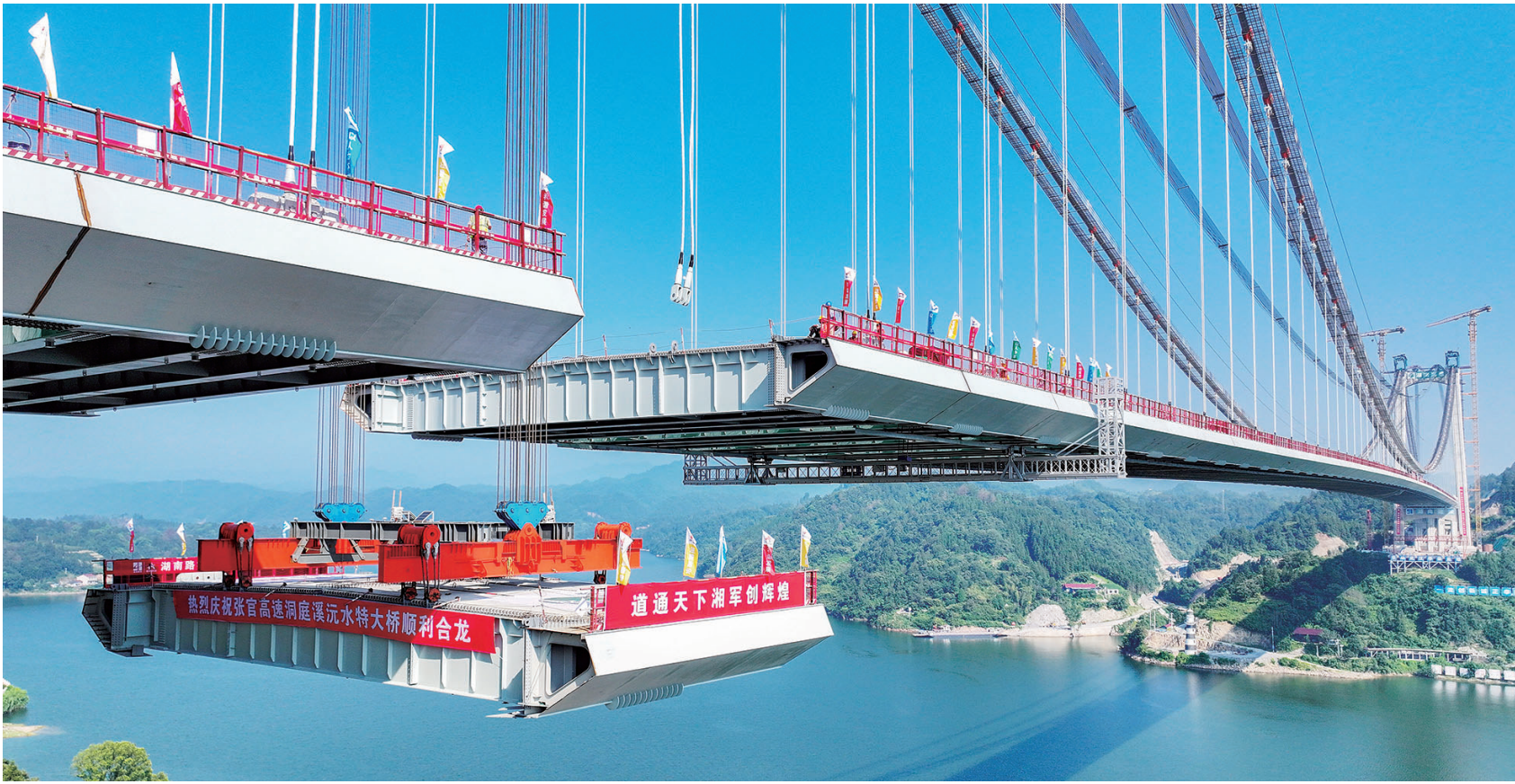
8月3日上午,位于沅陵县清浪乡境内的洞庭溪沅水特大桥项目施工现场,工人在吊装最后一节钢混组合梁。
