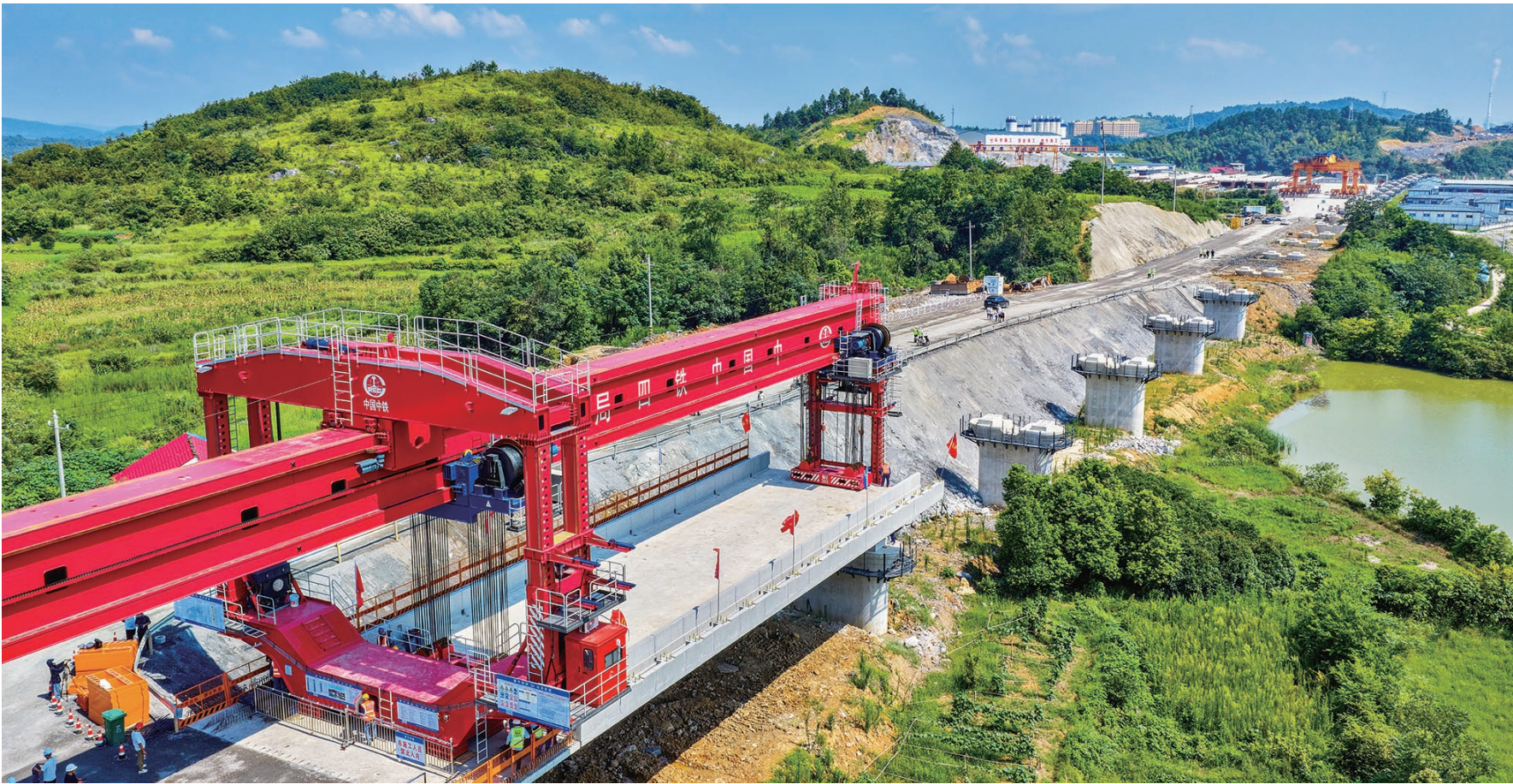
8月1日,邵(阳)永(州)铁路邵阳段首榀箱梁在园塘村特大桥成功架设,标志着由沪昆客专湖南公司建设、中铁四局承建的邵永铁路1标正式进入桥梁上部结构施工阶段。邵永高速铁路是国家“八纵八横”呼南高速铁路的重要组成部分,也是湖南省“十四五”铁路发展规划重点建设项目之一。
