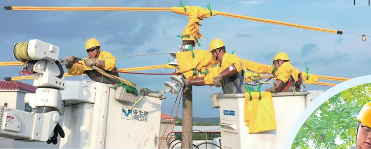
↑7月21日,国网邵阳供电公司带电作业人员在邵阳市大祥区新城大道10千伏檀体线35号杆开展线路直线改耐张带电作业。 刘元辉 摄
