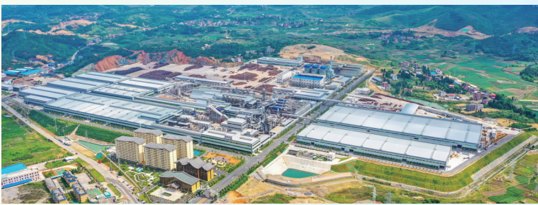
湖南鲁丽绿色新材料科技产业园全景。
