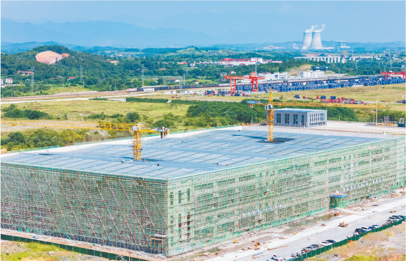
7月16日，永州市冷水滩区永州陆港冷链物流园（一期）两仓项目建设现场，工人正在进行屋面层施工。该项目建成后将有效整合区域物流资源，提升跨境贸易便利化水平，为永州及周边地区提供专业化、智能化的仓储分拨服务，助力经济高质量发展。 雷中祥 蒋凌志 摄影报道 (湖南图片库)
