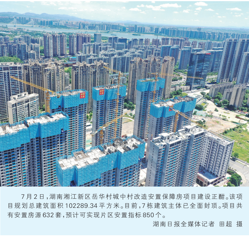
7月2日，湖南湘江新区岳华村城中村改造安置保障房项目建设正酣。该项目规划总建筑面积102289.34平方米。目前，7栋建筑主体已全面封顶。项目共有安置房源632套，预计可实现片区安置指标850个。
