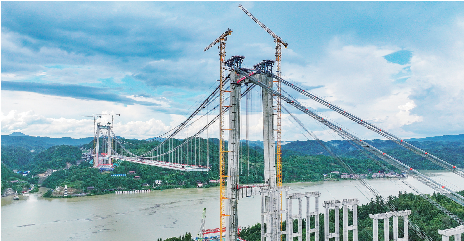
7月1日,位于沅陵县清浪乡的洞庭沅水特大桥项目,正在紧张施工。该大桥由湖南路桥建设集团公司承建,是国家高速公路网纵向主干线呼北高速张(家界)官(庄)段控制性工程之一,大桥全长1707米,主跨800米双塔单跨悬索桥,跨越沅水和五强溪国家湿地公园,是湖南省在建最大跨径悬索桥。
