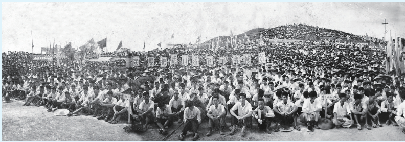
1965年7月1日，韶山灌区工程开工建设。
