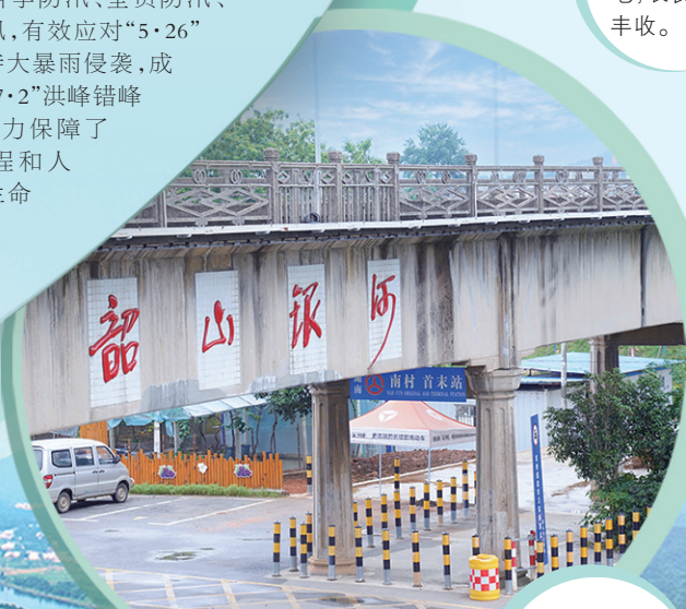
今年3月，韶山银河渡槽成功实施移位纠偏工程。
