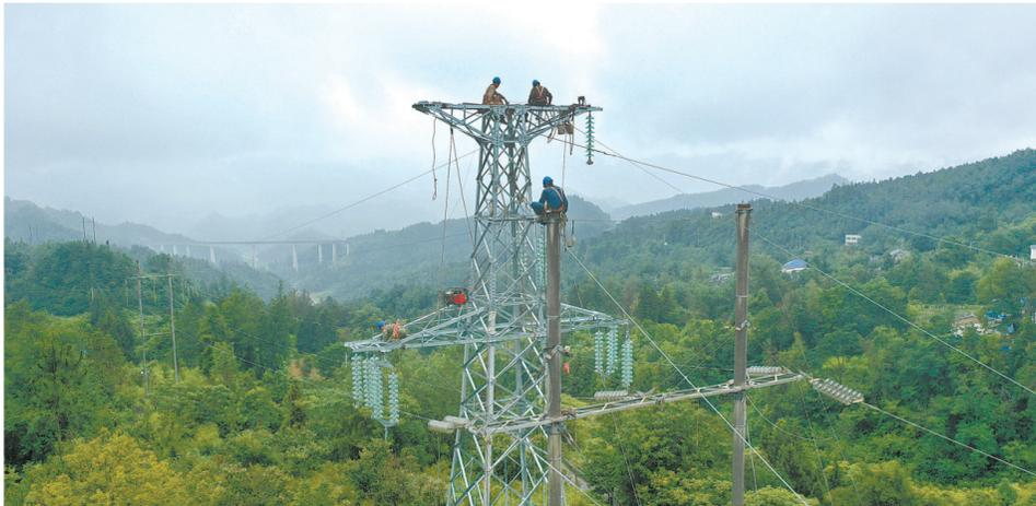
6月28日，龙山县岩溪镇马失村，电力工人正在进行110千伏枫林线双排杆更换铁塔作业。近期，该县对110千伏枫林线进行大修技改，保障电力稳定供应，提高运行效率。 曾祥辉 田良东 摄影报道 (湖南图片库)
