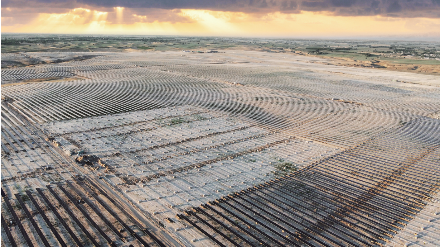
在乌兹别克斯坦塔什干州布卡区,由中国东方电气集团有限公司承建的乌兹别克斯坦布卡263兆瓦光伏发电项目正在建设中,建成后每年可发电超过57万兆瓦时,将助力乌能源结构转型,迈向绿色低碳发展。图为5月11日拍摄的位于乌兹别克斯坦塔什干州布卡区的263兆瓦光伏发电项目(无人机照片)。
