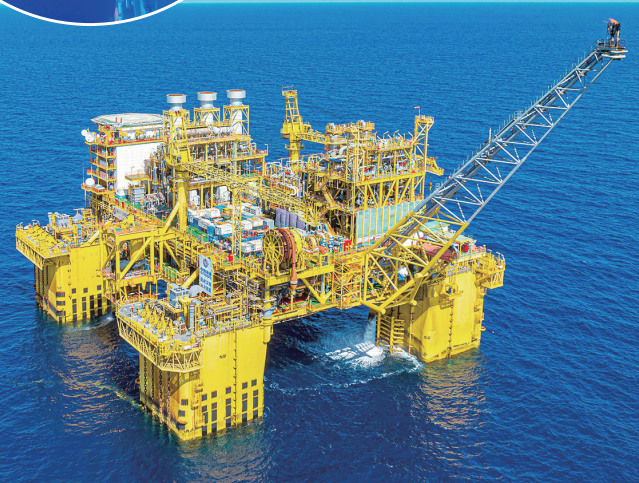
6月25日,中国海油宣布,在南海水域的“深海一号”大气田二期项目全面投产,标志着我国最大海上气田建成。
