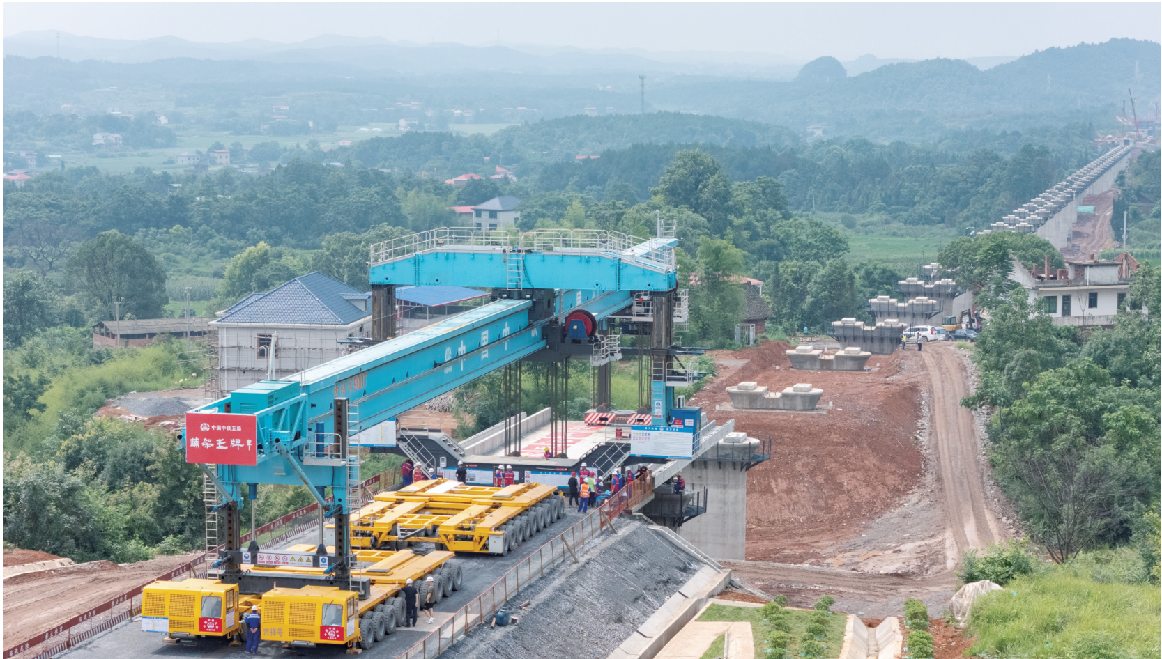
6月25日，永州市邵（阳）永（州）铁路完成全线首榀箱梁架设。图为柘刺坪特大桥施工现场。
