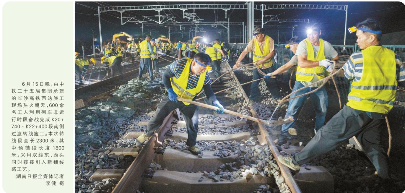
6月15日晚,由中铁二十五局集团承建的长沙高铁西站施工现场热火朝天,600余名工人利用列车非运行时段奋战完成K20+740~K22+400段南侧过渡转线施工。本次转线段全长2300米,其中预铺段长度1800米,采用双线东、西头同时拨接引入新铺线路工艺。
