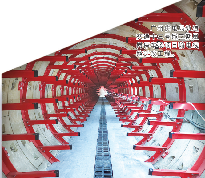
广州供电局轨道交通十三号线二期凤凰岗停车场项目输电线路迁改工程。
