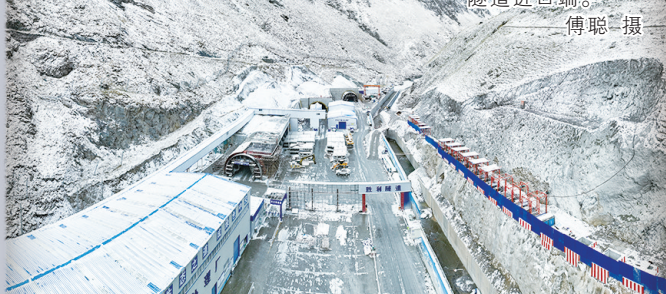
新疆乌尉(乌鲁木齐—尉犁)高速公路天山胜利隧道进洞端。
