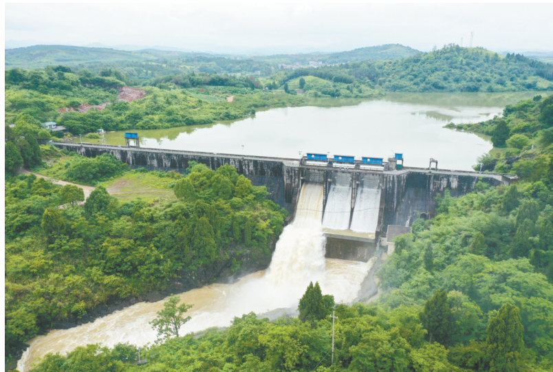
5月19日,嘉禾县观音山水库开闸泄洪。连日来,受持续强降雨和上游来水影响,该水库水位上涨。为安全度汛,当地适时开启水闸泄洪,确保水库及流域内人民生命财产安全。 黄春涛 摄(湖南图片库)
