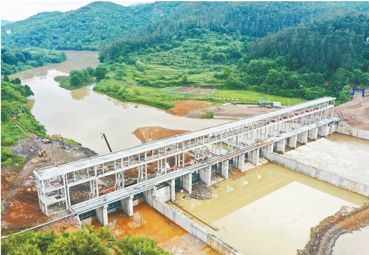
5月8日，嘉禾县上坪水闸工程现场，工人正在进行施工。该项目是以灌溉为主、兼顾防洪和水力发电等效益的综合性重点水利工程，建成后可有效提高河道防洪、农田灌溉、发电排灌、耕地保护能力，为农业丰收打下坚实基础。黄春涛 摄(湖南图片库)
