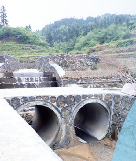
州门司镇上坪村小型防洪工程。
