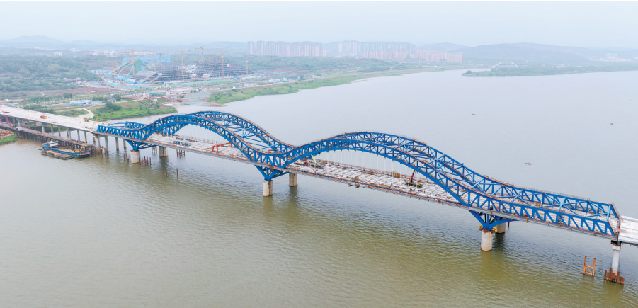
4月22日，俯瞰暮坪湘江特大桥建设现场，工人正加速推进施工。目前大桥稳步推进桥面板架设、人行道块体架设等后续施工。建成后将极大缓解长沙城南的过江压力，市民往返大王山和长沙南部片区通行时间，将由原来50分钟左右左右缩短至10分钟。湖南日报全媒体记者 辜鹏博 摄
