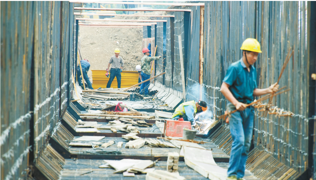
4 月 19 日，澧县澧浦街道十回港村引水涵洞建设现场，工人在紧张施工。作为引澧（澧水）入湖（北民湖）项目的控制性工程，目前该项目已进入钢筋混凝土洞体浇筑施工阶段，力争如期高质量完成任务。项目建成后，将有效保障北民湖水体实现生态循环和湖区 6 万余亩农田灌溉用水。 柏依朴 摄（湖南图片库）
