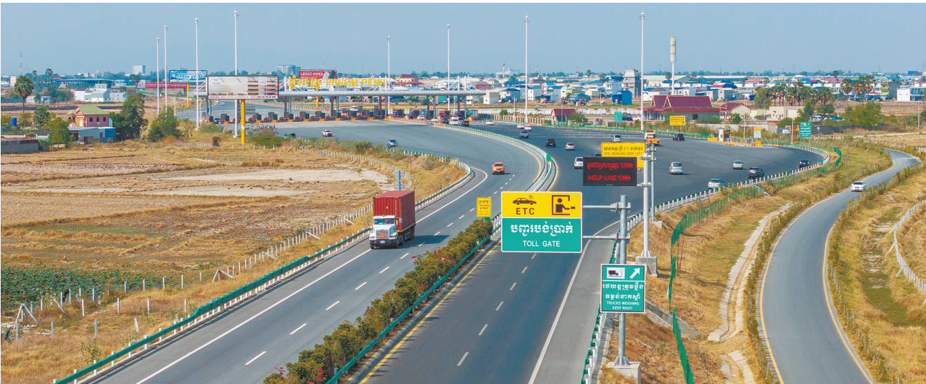
3月15日拍摄的柬埔寨第一条高速公路——金港高速公路的金边收费站（无人机照片）。金港高速连接柬埔寨首都金边和该国最大深水海港西哈努克港，是中国公司按“建造—运营—移交”模式投资的项目，如今已打造成中柬共建“一带一路”的标志性工程。新华社发
