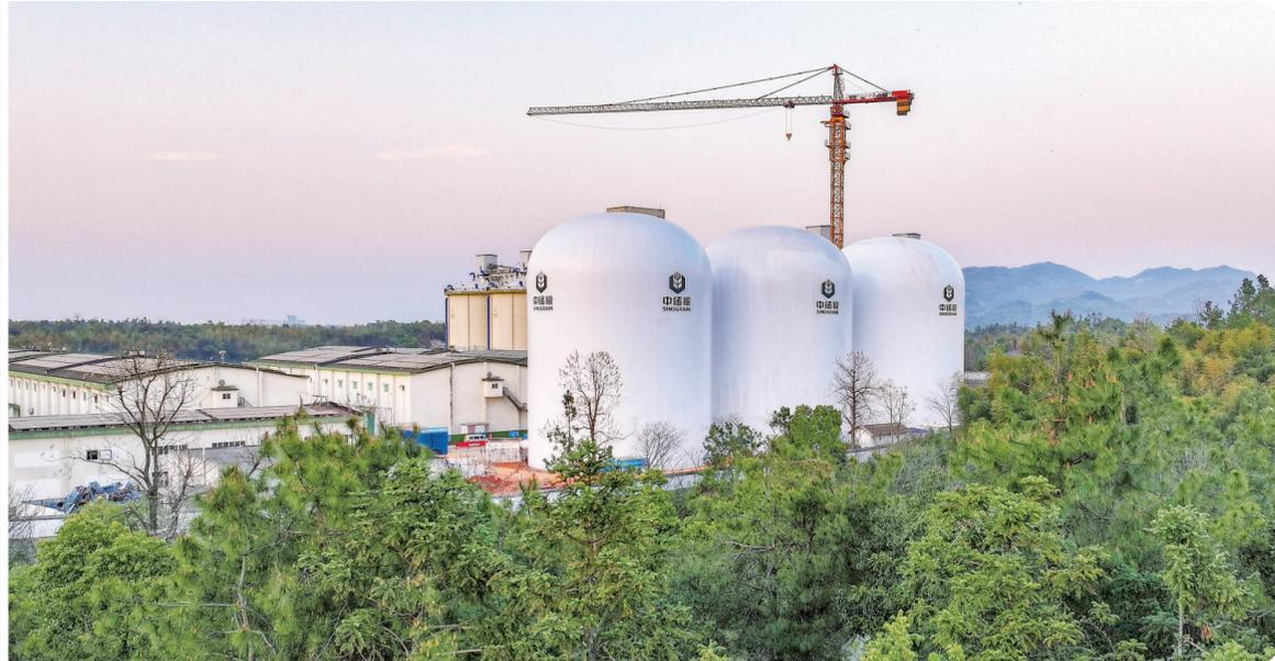
3月24日,三座9000吨级气膜粮仓在湖南完成仓体充气成型。这是中国首批9000吨级气膜粮仓项目群,单气膜仓体高度33米,直径24米,可储存粮食9000吨,仓容比前代技术提升20%。
