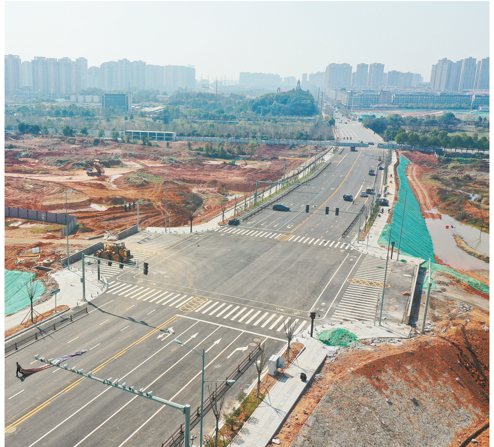
3月18日，长沙松雅湖东片区松雅湖南段建设已基本完成，进入最后的智能交通设备调试阶段。该段道路全长710米，双向四车道，是连接松雅湖国家湿地公园与松雅湖未来科技城的重要通道。 湖南日报全媒体记者 田超 摄
