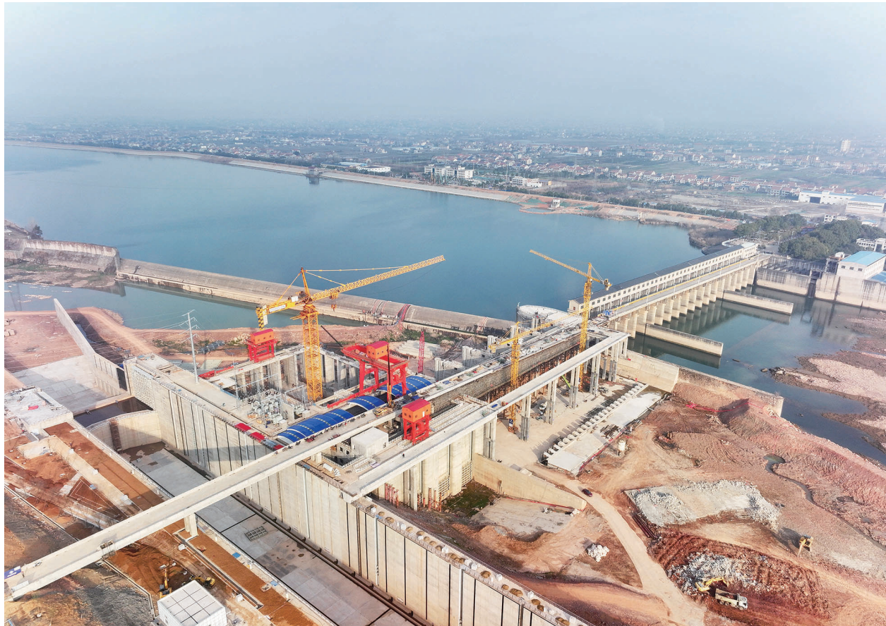
2月16日,建设中的澧水航道澧县枢纽工程。2月中旬,澧水航道澧县枢纽工程建设进入竣工决战阶段,中交二航局抓住有利天气组织工人紧张施工,确保如期完成任务。柏依朴 张若愚 摄(湖南图片库)
